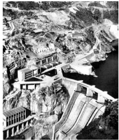
Central Hidroeléctrica do Picote, Miranda do Douro.
