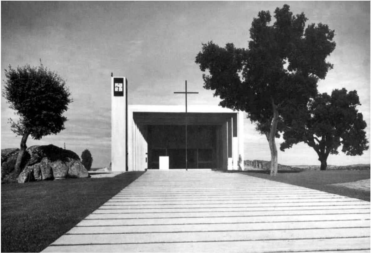
Manuel Nunes de Almeida, Capilla de Nuestra Señora de Fátima, Central Hidroeléctrica de Picote, Miranda do Douro (Portugal), 1956/58.
