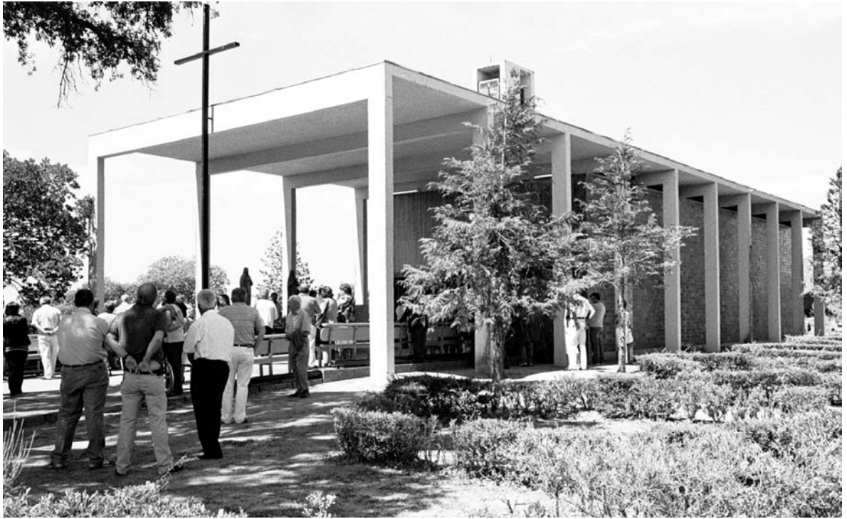
Capilla de Picote. Estado actual.
