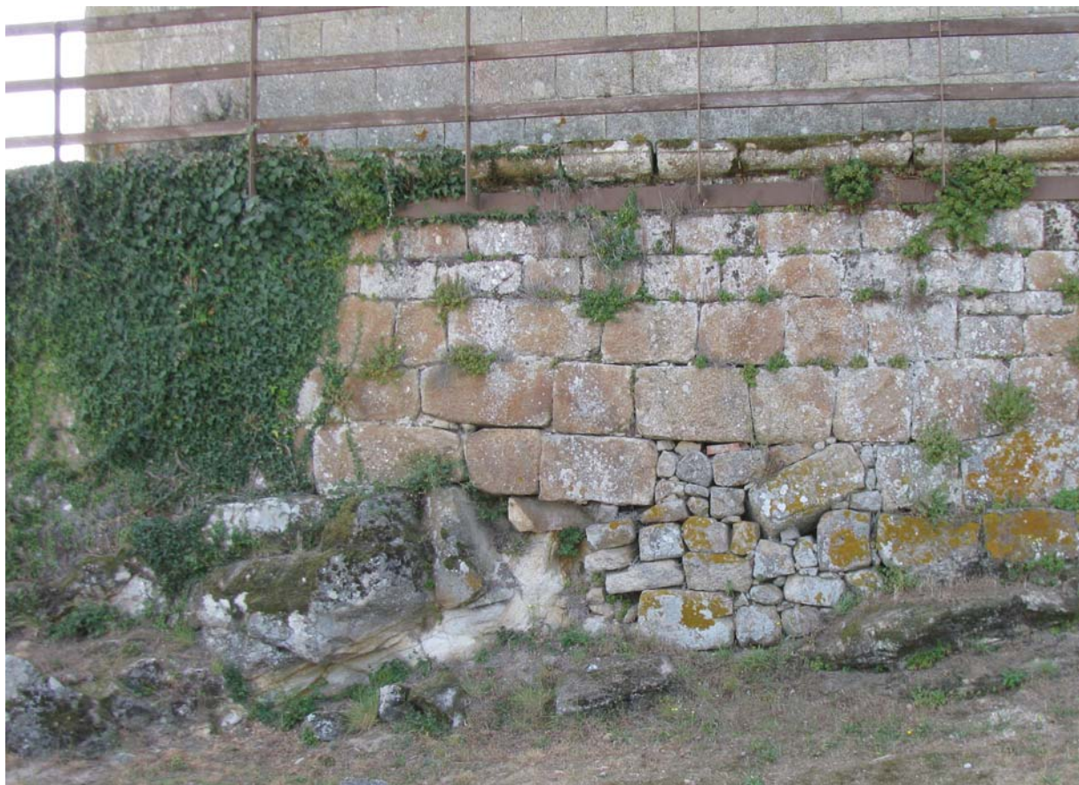
Fig. 5. Efeito em estrutura humana da instabilidade no maciço rochoso na base da estrutura.
