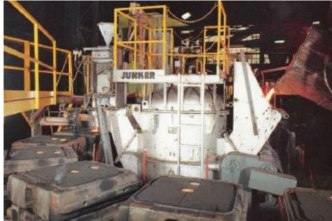
Imagen 10.1: Horno de colada Otto Junker RGD
