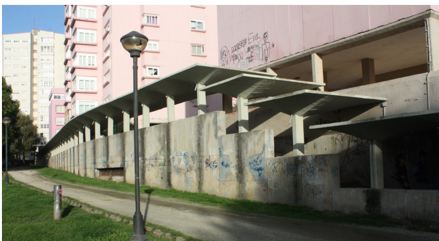
15. Cambio de nivel del corredor de paraboloides entre plazas.
