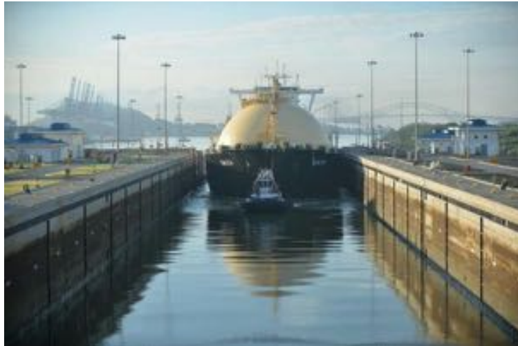
Fig. 8 - Galea, el primer Kvaerner Moss type LNG carrier, pasando el Canal 26/08/2016. Fuente: PCA
