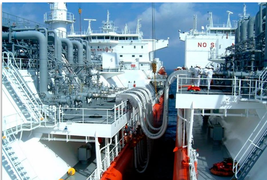
Imagen 16: Mangueras criogénicas para GNL en operación de transferencia.
