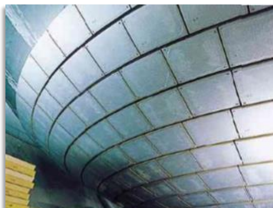
Imagen 23: Voidspace en un tanque esférico tipo Moss Rosenberg
