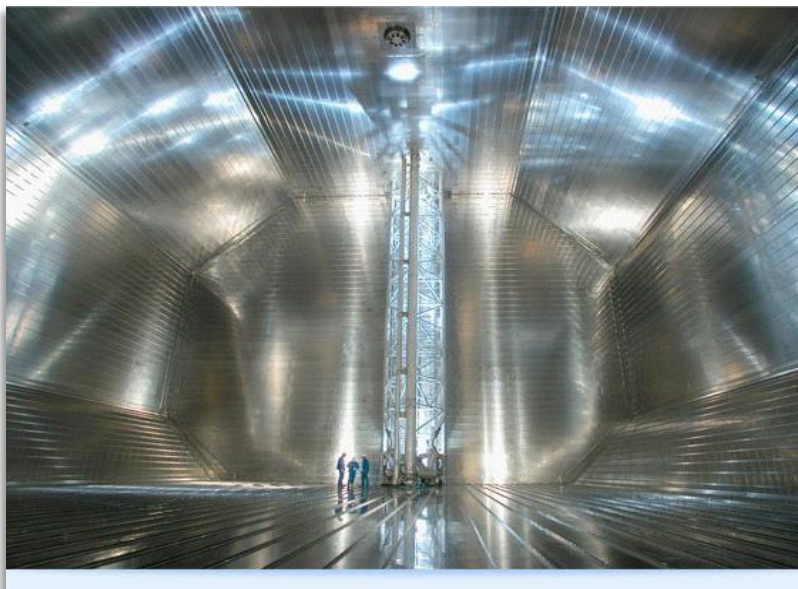
Imagen 30: Tanque con sistema Gaztransport-Technigaz CS1.
