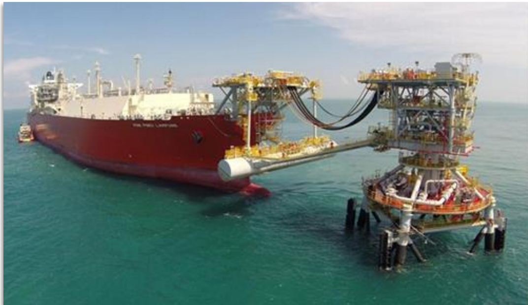
Imagen 42: Torre SPM (Single Point Mooring).
