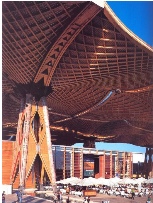
Figura 18: Expo-Roof (Herzog, Natterer). Exposición Universal de Hannover 2000 Fuente: Herzog, 2001.
