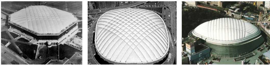
Figura 13: Algunos de los edificios consecuencia del Pabellón de los Estados Unidos en la Expo de Osaka 1970. De izda. a drcha: Pontiac Silverdome, David Geiger 1975; Estadio BC Place de Vancouver, David Geiger y Horst Berger, 1983; Tokio Dome, Sekkei, Komuten, 1988. Fuentes: Izda. y centro: http://www.columbia.edu/cu/gsap/BT/DOMES/domes.html ; Drcha: Ishii, 1995.
