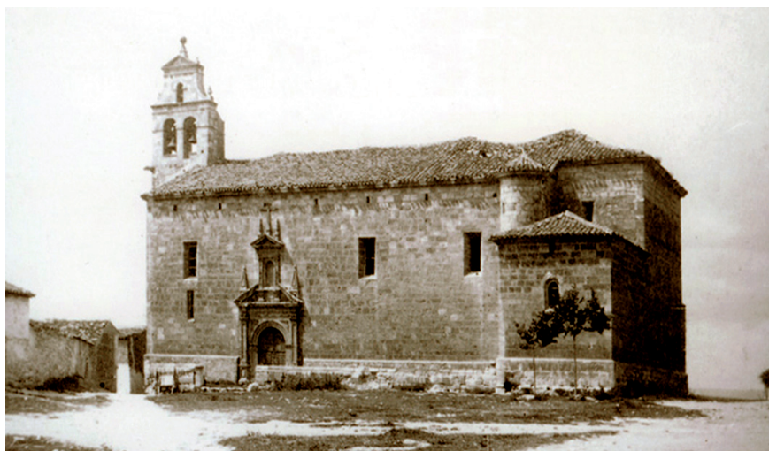
02 Estado de la antigua iglesia de san Juan Bautista, Alarcón (Cuenca), a finales del siglo XIX
