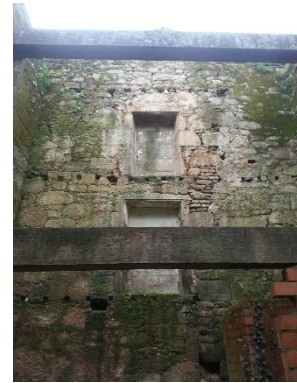
Cerramiento sur interior vivienda principal.
