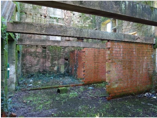
Cerramiento sur interior vivienda principal.
