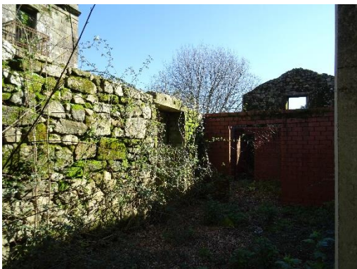
Cerramiento este interior vivienda auxiliar.
