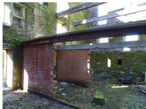
Cerramientos norte y oeste interior vivienda principal.
