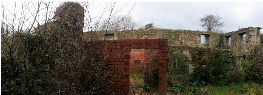
Fachada lateral este edificación auxiliar.
