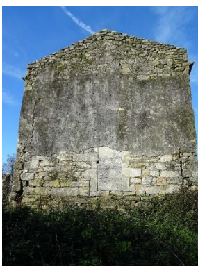
Fachada Sur vivienda principal.
