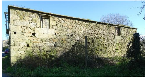
Fachada lateral oeste edificación auxiliar.
