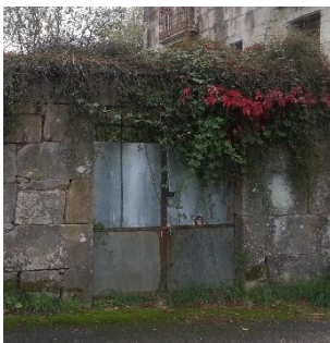
Acceso a patio II.
