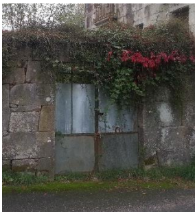
Portal acceso a patio II.
