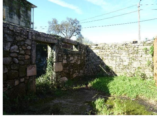
Cerramientos norte y oeste anexo I.
