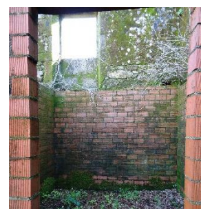
Cerramiento Sur interior vivienda auxiliar.
