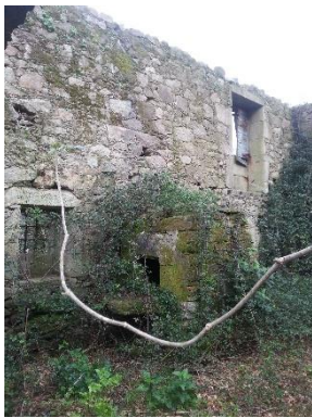
Horno interior vivienda auxiliar.
