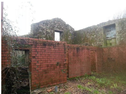
Cerramientos Sur y Oeste interior vivienda auxiliar.
