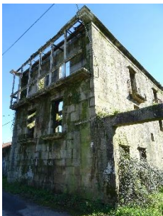
Fachada norte edificación principal.
