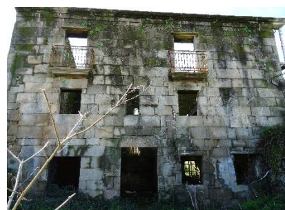
Fachada lateral este edificación principal.
