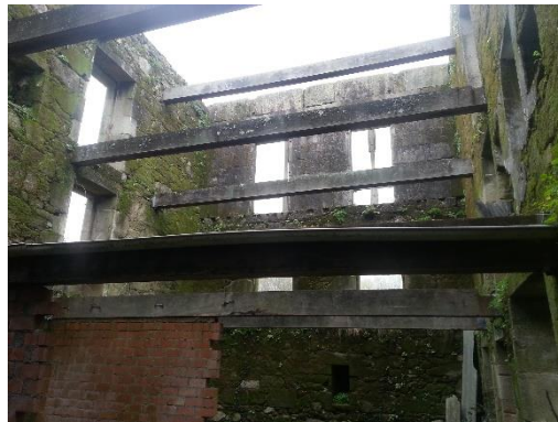
Cerramiento norte interior vivienda principal.
