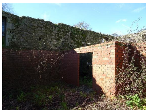
Cerramiento Oeste interior vivienda auxiliar.
