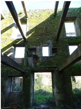
Cerramiento este interior vivienda principal.
