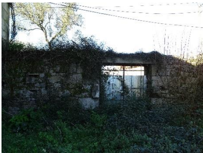
Muro de cierre.
