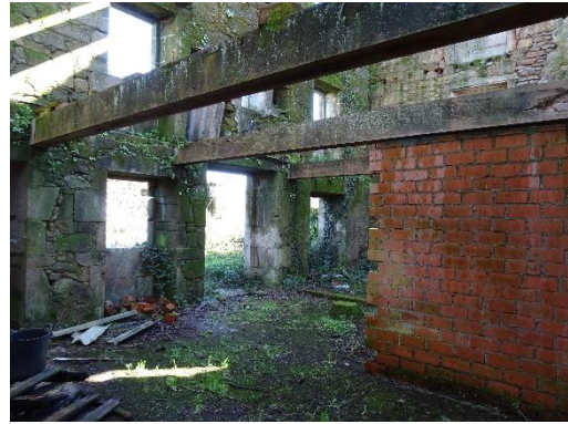
Cerramiento este interior vivienda principal.
