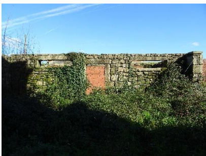
Fachada anexo I.
