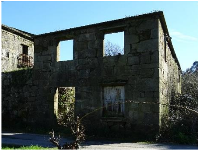
Fachada norte edificación auxiliar.
