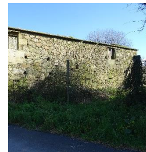
Acceso a parcela por lateral de vivienda auxiliar.
