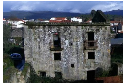
Fachada lateral oeste edificación principal.
