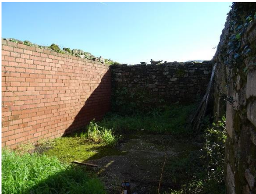
Cerramiento sur anexo I.
