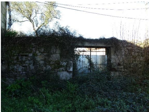
Cerramiento y acceso a patio II.
