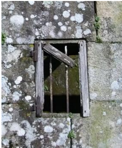
Hueco iluminación escaleras.
