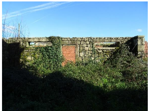
Fachada anexo I desde patio II.
