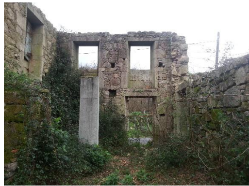
Cerramiento norte interior vivienda auxiliar.
