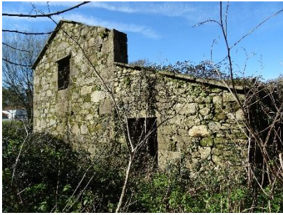
Fachada sur edificación auxiliar.
