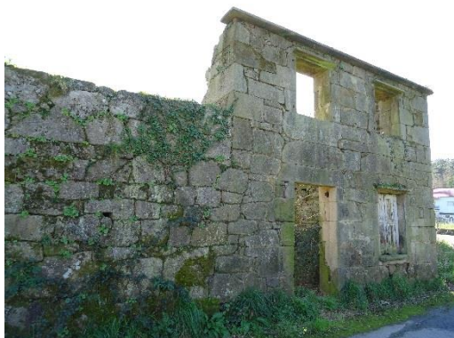
Fachada Norte vivienda auxiliar.
