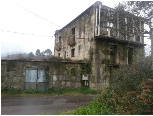
Fachada Norte vivienda principal y acceso patio II.
