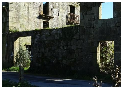
Acceso a patio I y a interior vivienda auxiliar.
