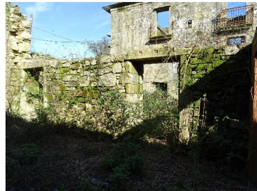
Cerramiento este interior vivienda auxiliar.
