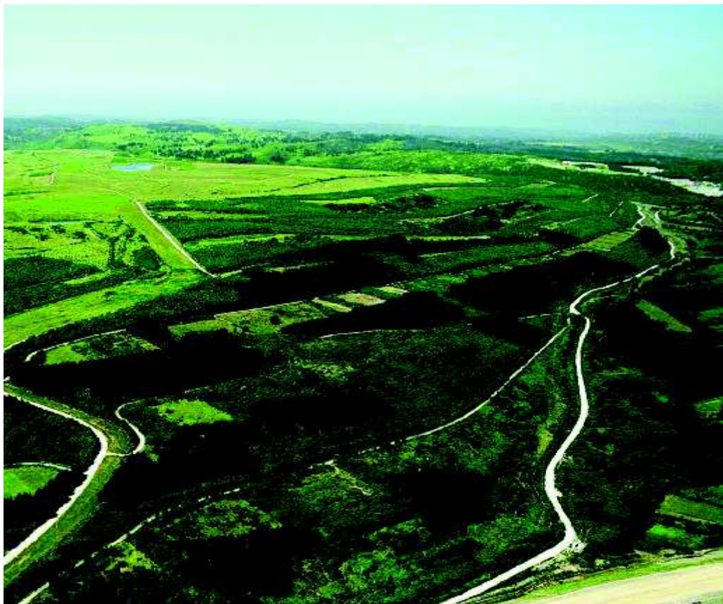
Imagen 20: Vista panorámica (I) de la escombrera exterior. As Pontes de García Rodríguez. (Aréchaga, F.; Ferrero, T.; Gil, A.; Menéndez, J. A. y Valle, R.; 2011).
