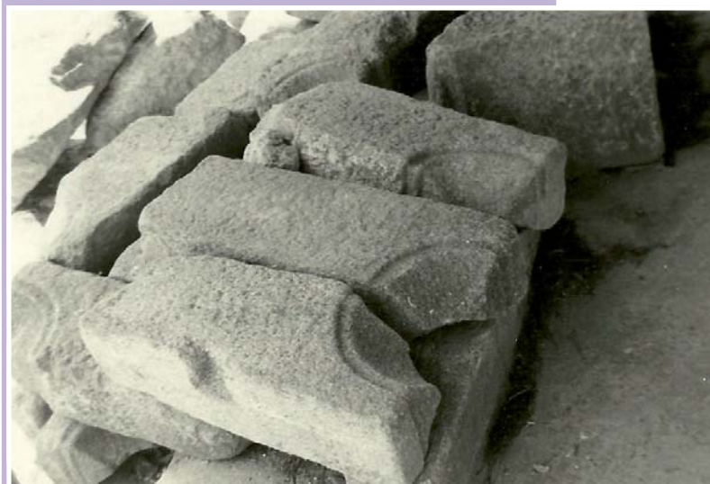
73.- Restos de la iglesia románica, canchales de los muros laterales desmontados en las obras de 1820 (foto JRS-1976)
