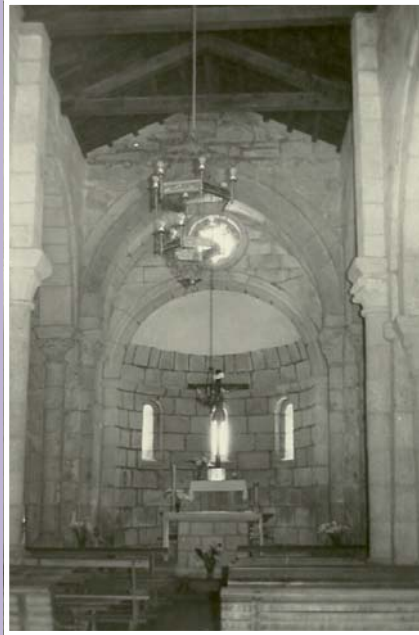
74.- San Tomé sin el retablo mayor desmontado en la restauración a mediados del siglo XX (foto JRS- 1976)
