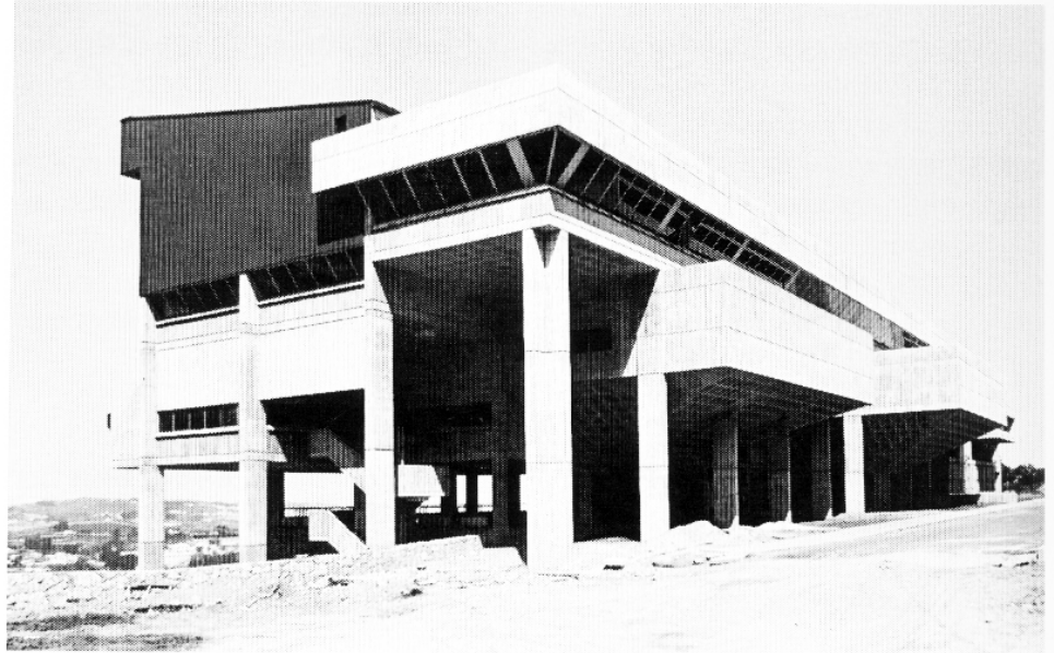
Fig. 3. Escuela de Aparejadores en construcción.
