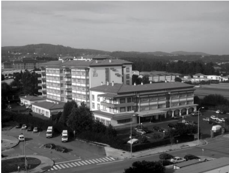
Figura 1. Centro de Atención a Personas con Discapacidad Física (CAMF) de Ferrol.
