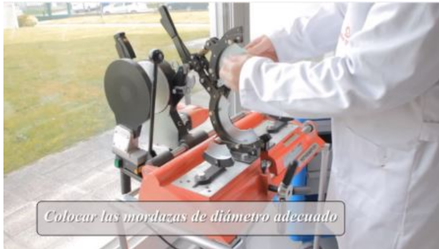
Imagen 8.4 colocación de mordazas
