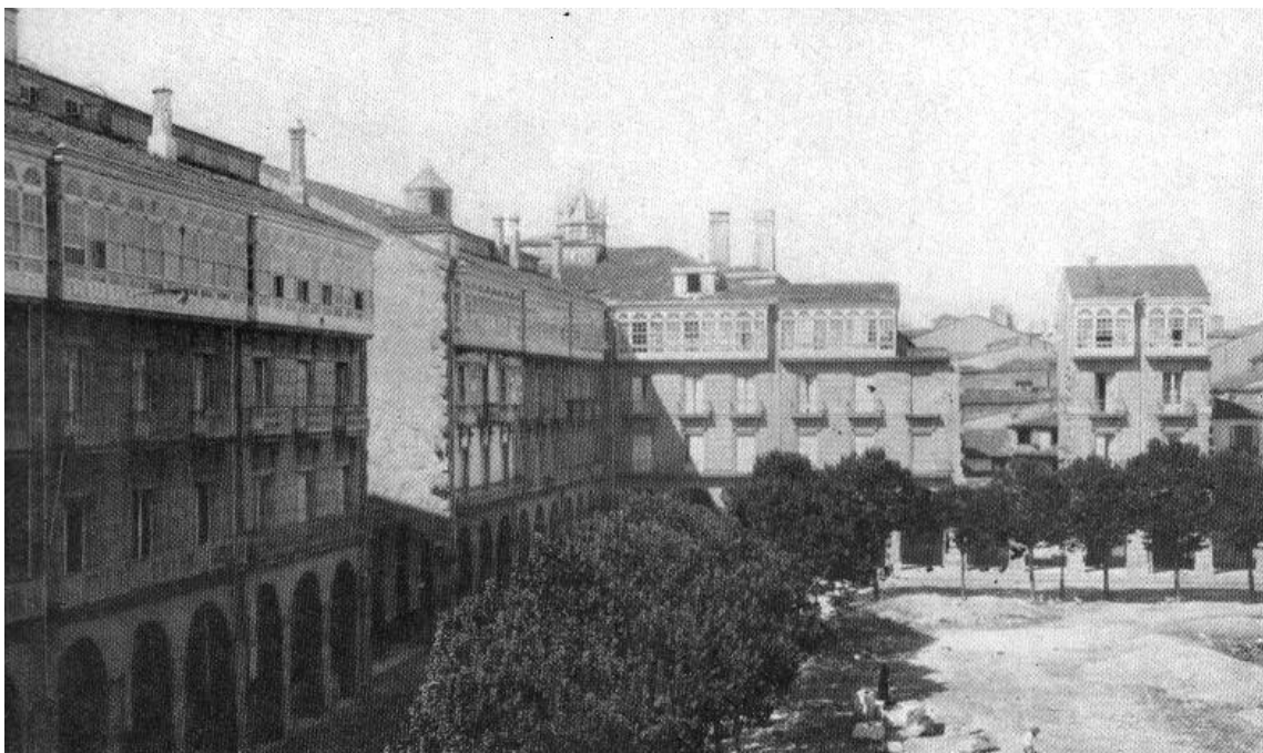
7.- Plaza María Pita en construcción en las primeras décadas del siglo XX.
