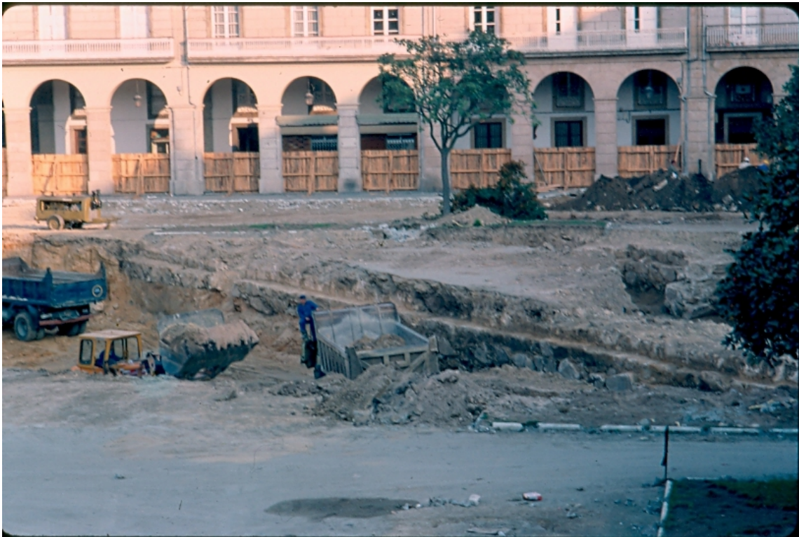
4.- Excavación del aparcamiento en la plaza María Pita, con los restos de las murallas, antes de su demolición.
