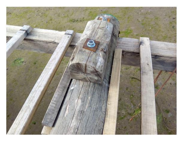
Figura 19 – Tope de seguridad de la cadena del muerto y pequeños largos de desgaste instalados en la viga central.
