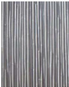
\_El acabado de los paneles es texturizado, mediante el empleo de moldes con el negativo de la textura a obtener, evitando los relieves que favorecen la formación o depósitos de suciedad, mejorando el mantenimiento de la fachada.
