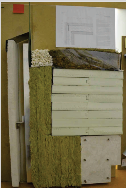
Imaxe 9. Detalle construtivo 1 (foto da autora). Maqueta da sección construtiva das vivendas de Astana exposta no departamento de construción da ETSAC, realizada polos alumnos Iago Otero Regueira e Miriam Nuñez Guerrero.
