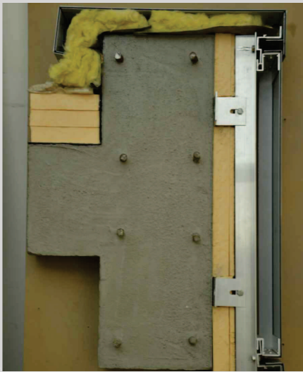
Imaxe 10. Detalle construtivo 2 (foto da autora). Maqueta da sección construtiva dunha fachada ventilada exposta no departamento de construción da ETSAC, realizada polos alumnos Isabel Rendo Riveiro e Santiago Tarrío Goy.
