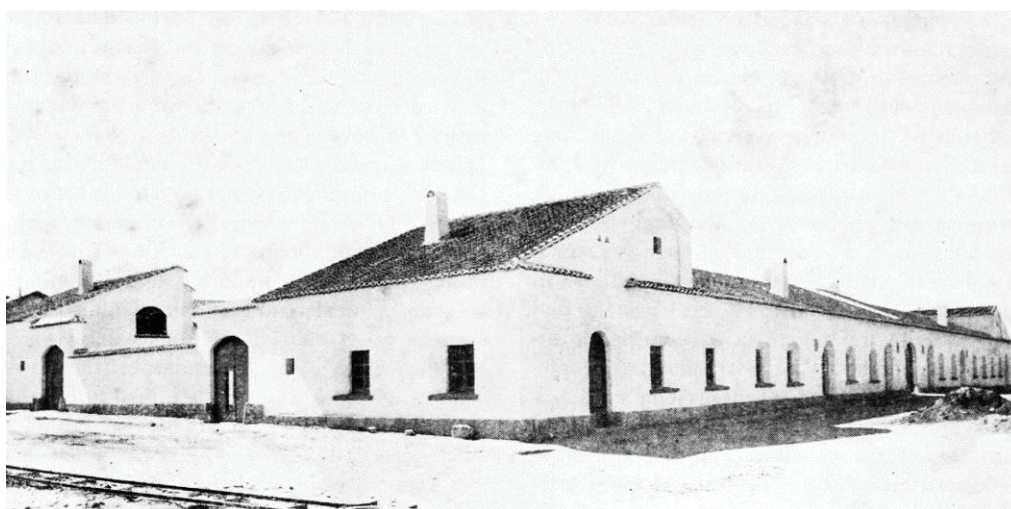
(Fig. 3) Viviendas para labradores en Villanueva de la Cañada. Reconstrucción nº 28
