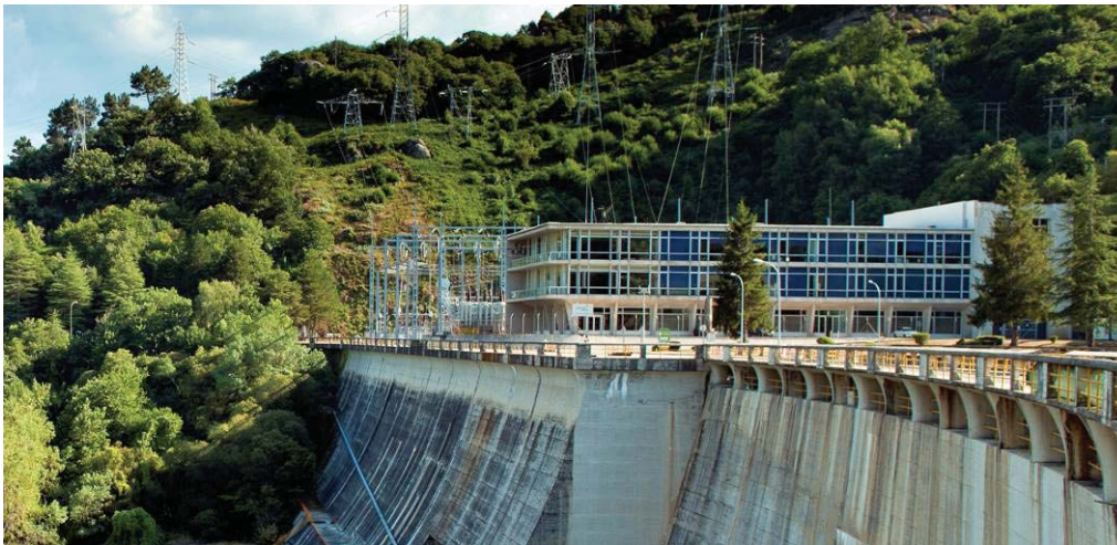
(Fig. 8) Edificio de la subestación de Belesar. Archivo Gas Natural Fenosa
