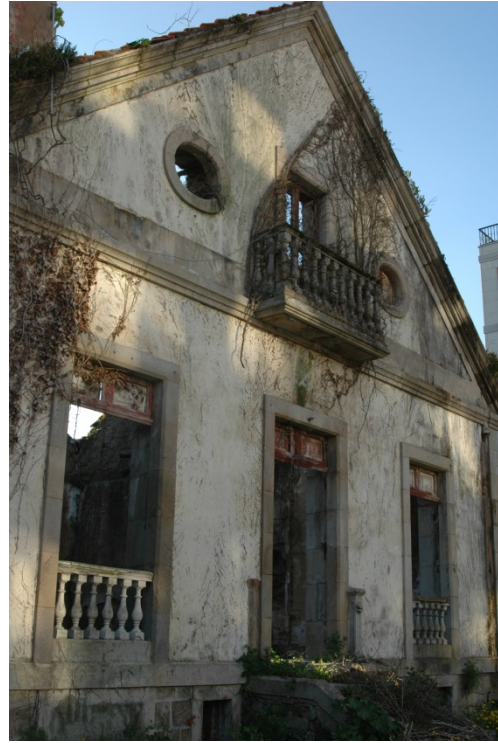
Imagen 23, fachada posterior (este).
