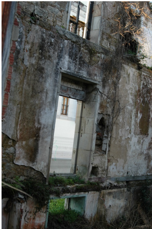
Imagen 28, interior fachada lateral (norte).
