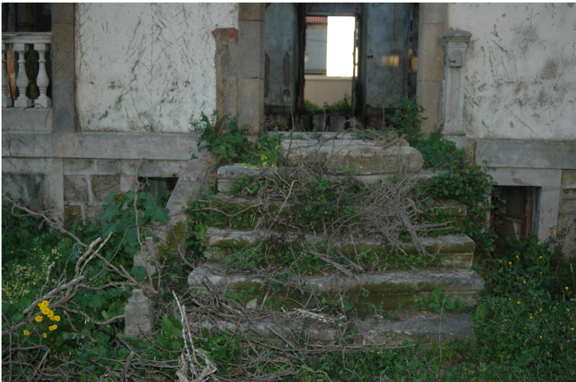
Imagen 31, detalle de alzado escalinata pétreo de acceso a la vivienda, correspondiente a la fachada posterior (este).
