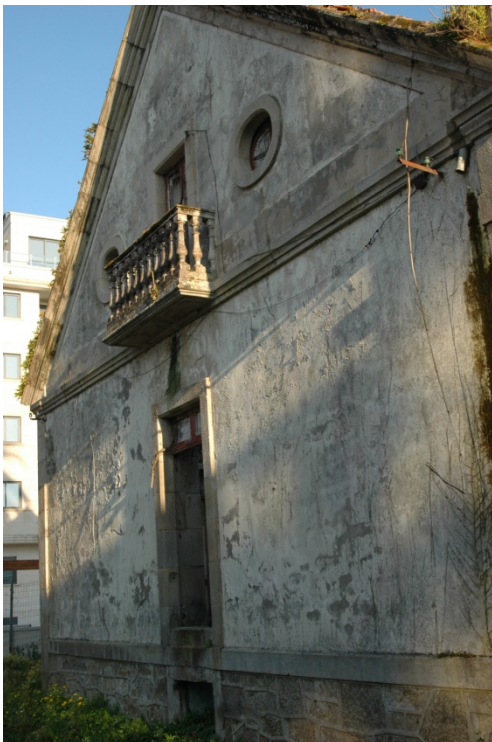
Imagen 24, fachada lateral (norte).
