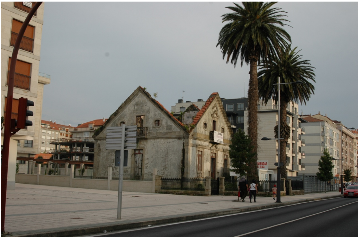
Imagen 35, vista general de la edificación, desde la Avenida Rosalía de Castro. Detalle de los dos tipos de cierres (original y nueva construcción) de la finca, y palmeras que coronan la entrada principal.
