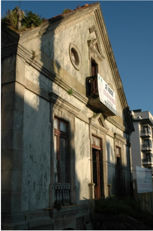
Imagen 22, fachada principal (oeste).
