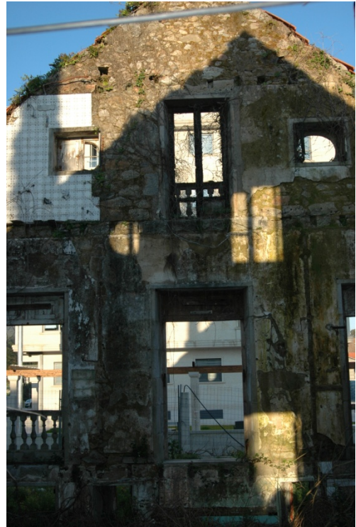
Imagen 27, interior fachada posterior (este).
