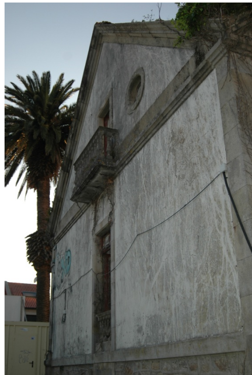
Imagen 25, fachada lateral (sur).
