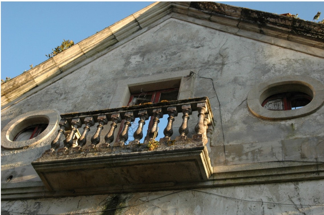
Imagen 33, detalle balcón y ventanas con forma de ojo de buey en la planta bajo cubierta.
