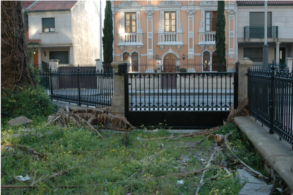
Imagen 30, detalle cierre original de la finca de reja de hierro fundido y zócalo de piedra.
