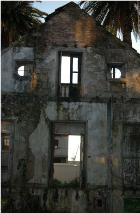
Imagen 26, interior fachada principal (oeste).
