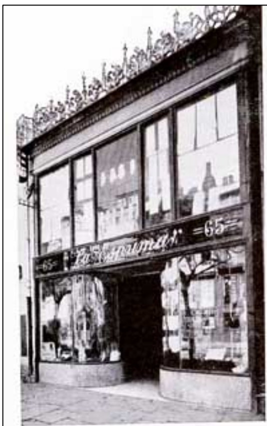
Fachada e interior de los almacenes La Espuma
