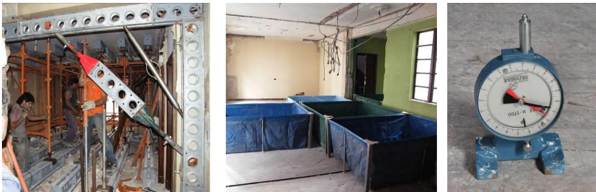
FIG.03: Prueba de carga de forjados y vigas
