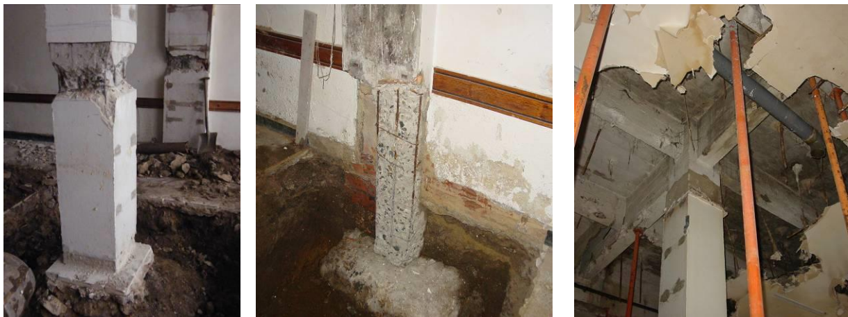
FIG.02: Proceso del levantamiento de datos: apertura de catas
