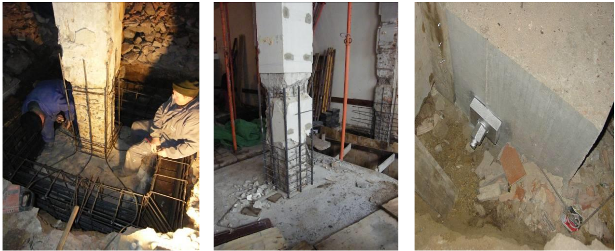
FIG.05: Refuerzo de zapatas aisladas y tendones de postesado
