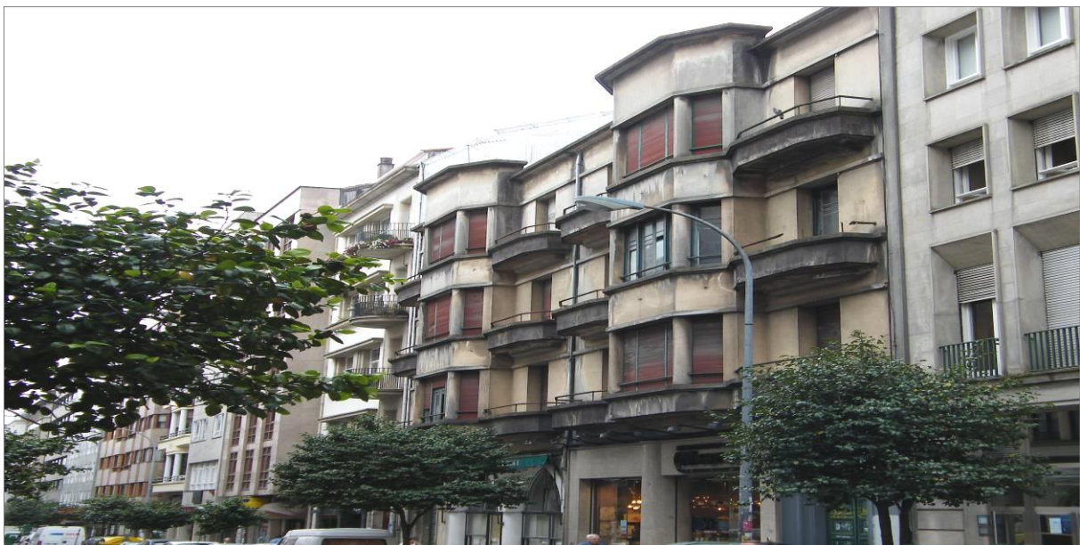
FIG.01: Fachada principal del edificio
