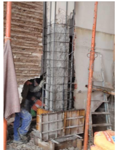
FIG.04: Refuerzo de pilares
