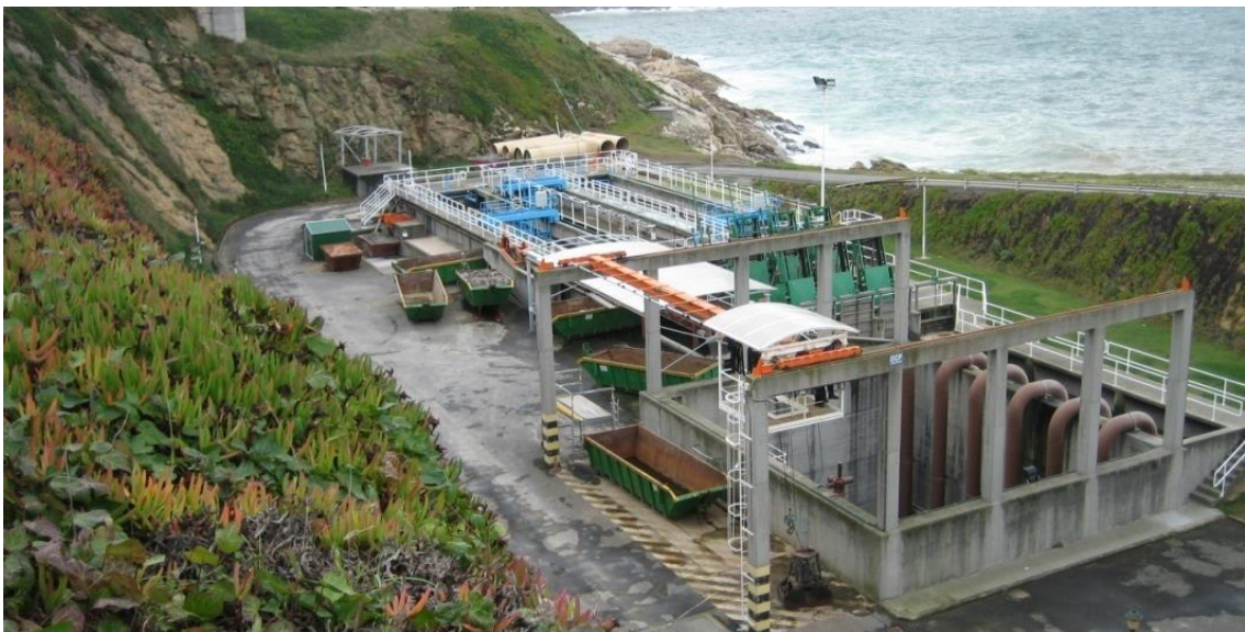
Figura 3.3.- Imagen de la antigua EDAR de Bens (pretratamiento) (año 2009)
