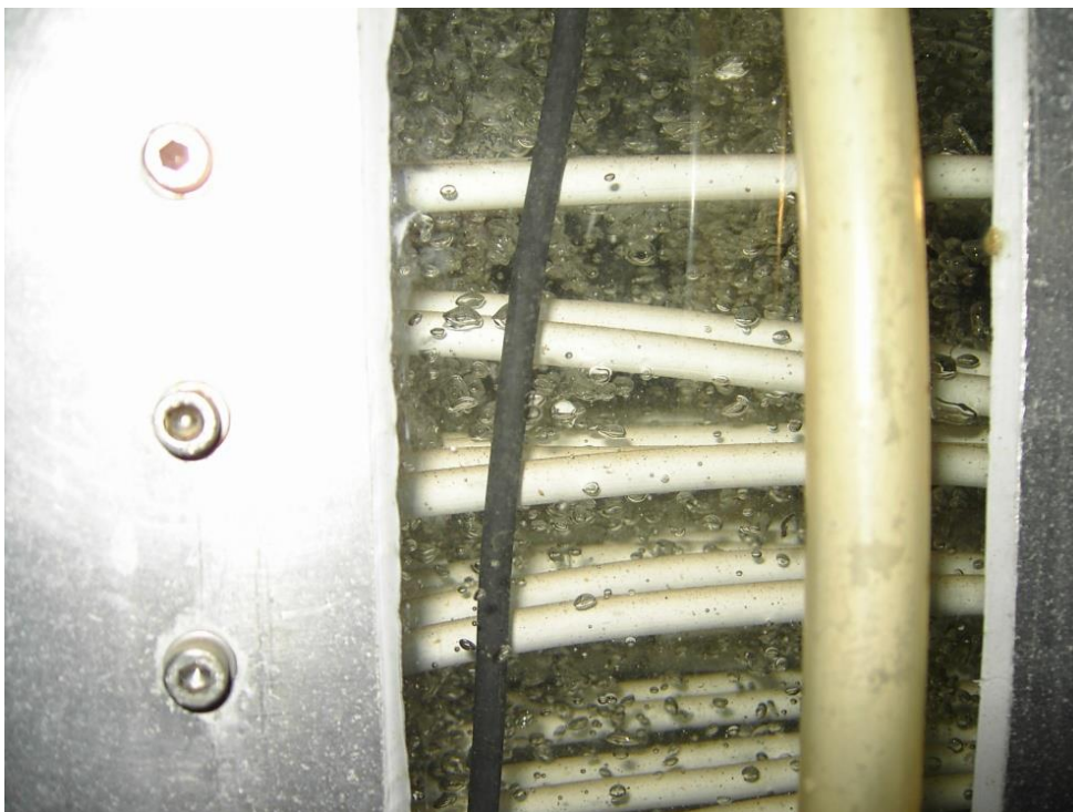
Figura 3.9.- La soplante en pruebas de funcionamiento. Se observa un burbujeo grueso en el seno líquido debido a la aireación a través de los difusores del fondo.
