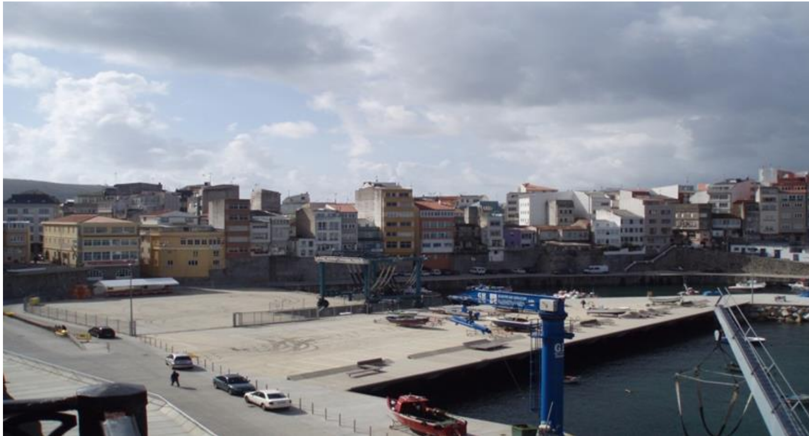
Figura 52. Vista da dársena no ano 2010.
