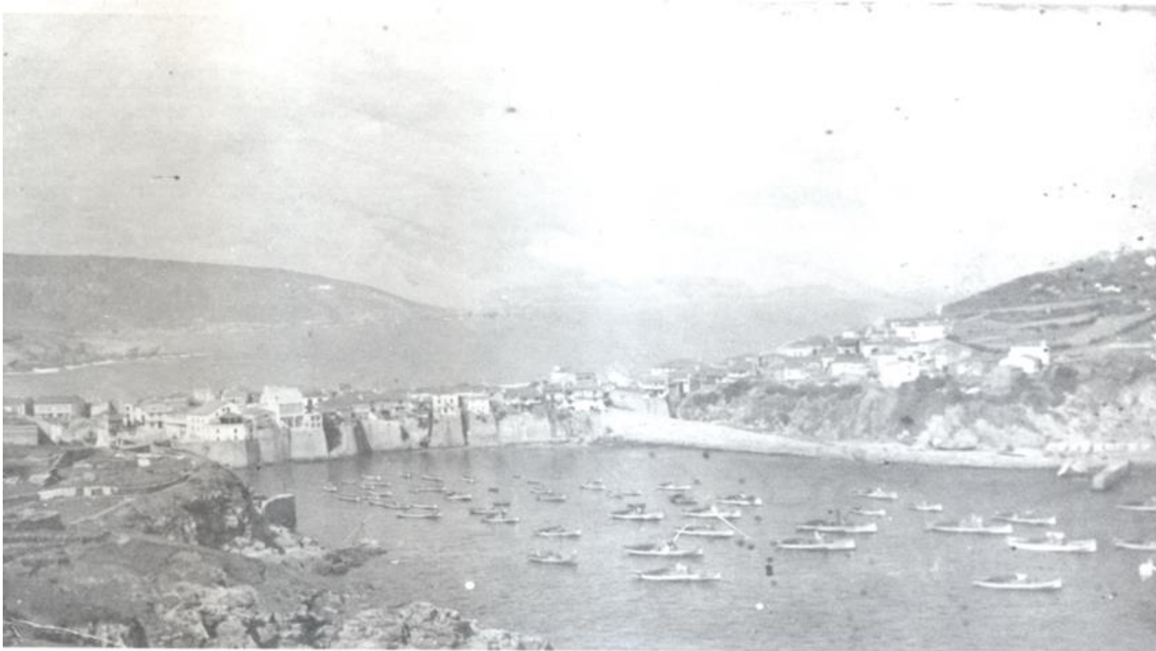
Figura 44. Vista do primeiro dique de abrigo década dos 40.
