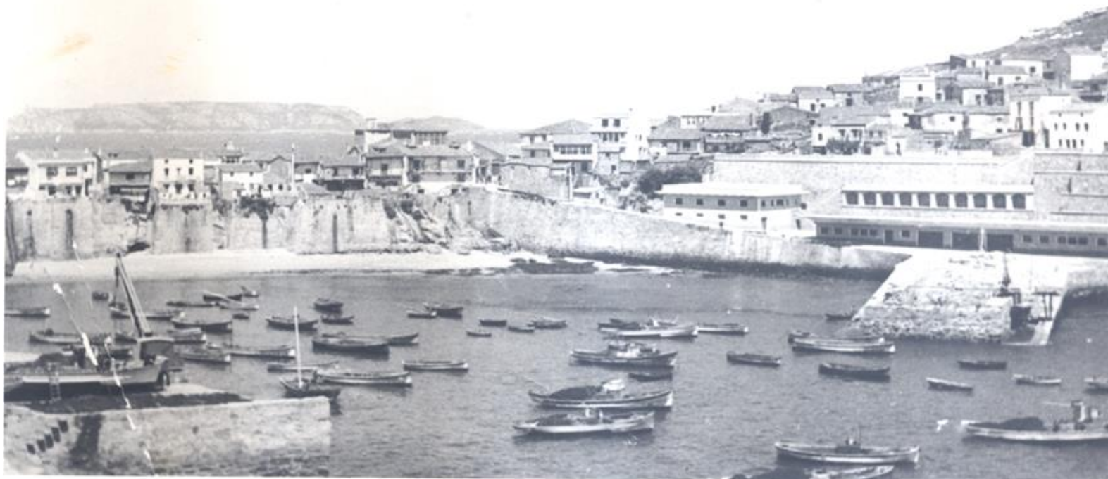
Figura 45. Vista da grúa, dársena e as obras do muro do gas no 1949.
