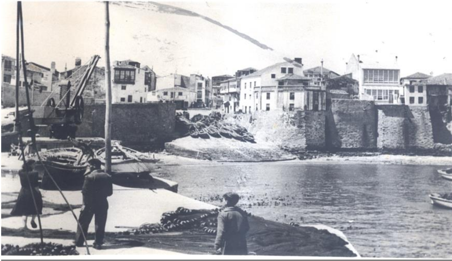
Figura 7. Vista da grúa e da rampla década a mediados dos 40.
