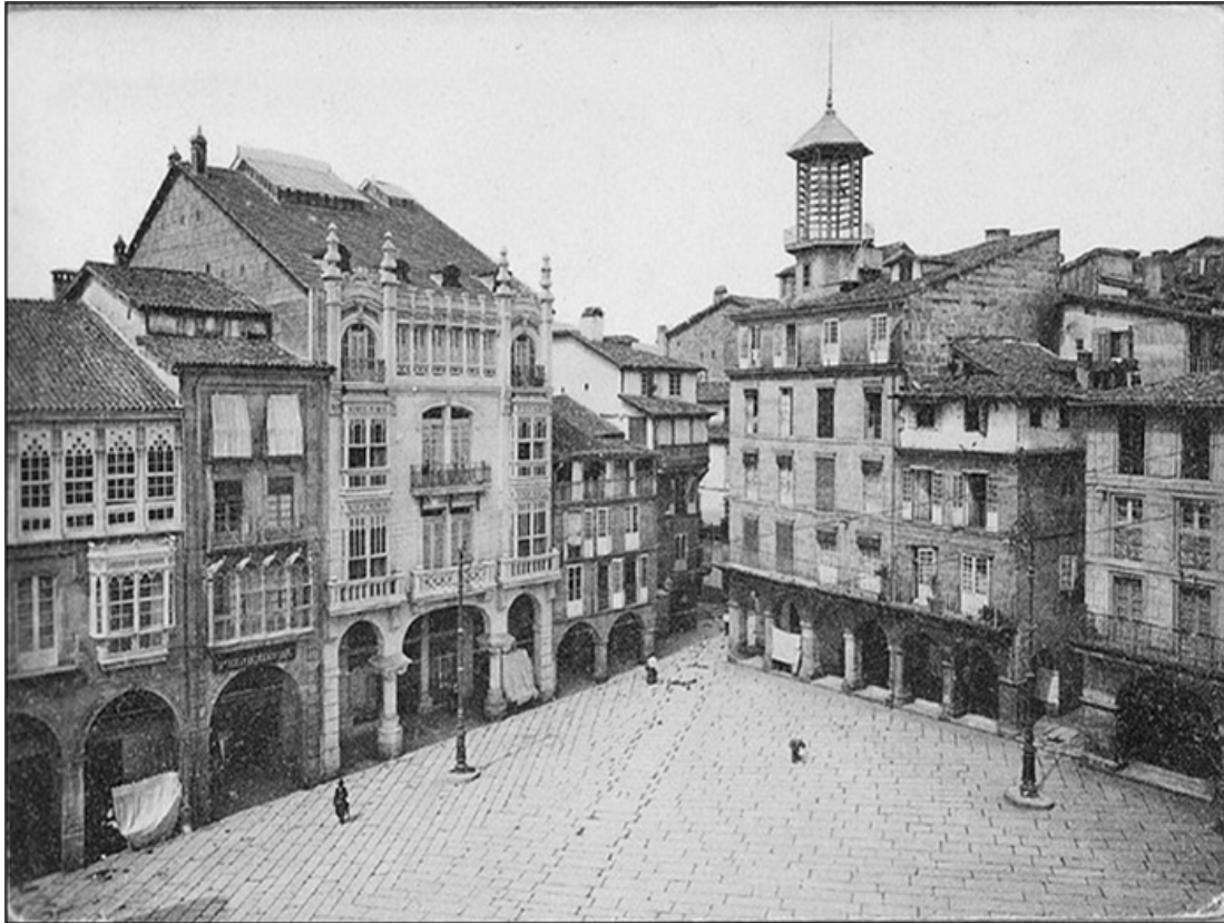
Edificio Lamas Carvajal nº 2 con torre telefónica.
