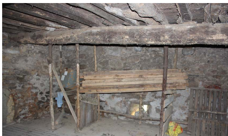
Vista en cocina del entramado horizontal de
