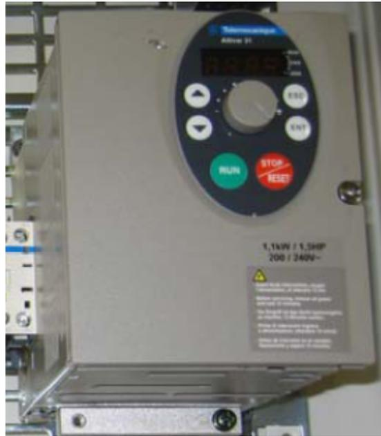
**Figura 7.1.5.10** – Variador de frecuencia ATV 31HU11M2A de Telemecanique
