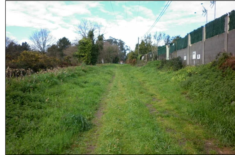
Fotografía Nº2: Rúa Maside. Tramo de la red de fecales proyectada de \varnothing 200 .
