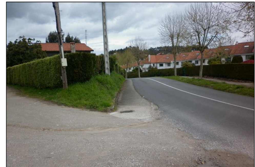
Fotografía Nº7: Arqueta de conexión de la red de pluviales proyectada con la red existente.
