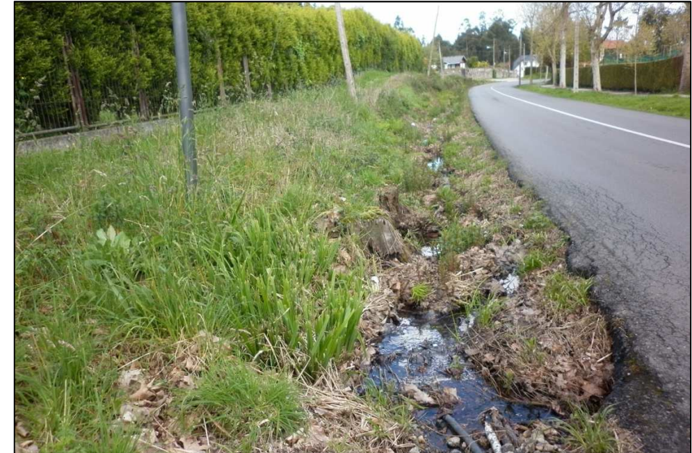
Fotografía Nº6: Avenida Isaac Díaz Pardo. Estado actual.
