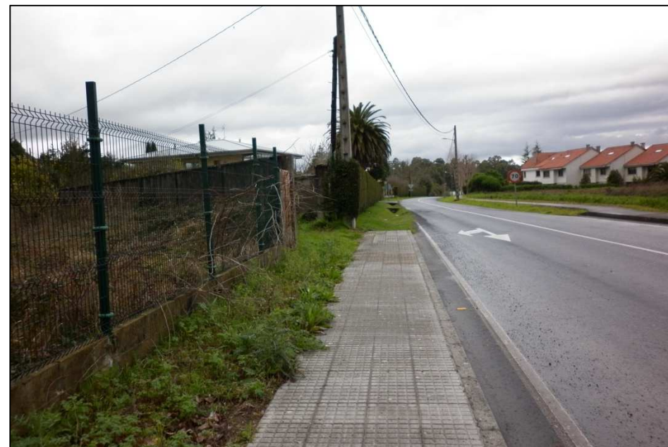
Fotografía Nº5: Avenida Isaac Díaz Pardo. Conexión Rúa das Mimosas con la carretera AC-190. Comienzo de la red de pluviales proyectada.
