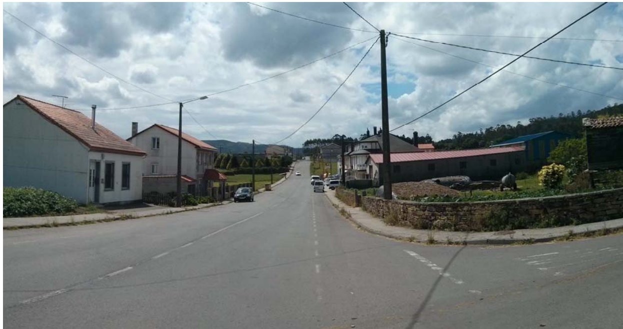
Foto 6. P.K 4+000. Inicio del tramo en el que el Concello ya ha actuado.
