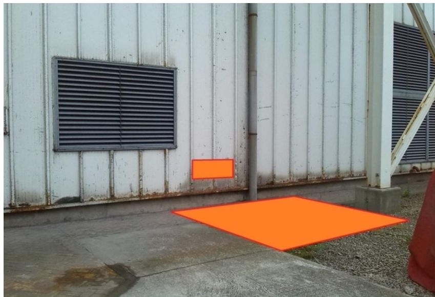
Figura .2.4.1-Lugar de emplazamiento de la planta frigorífica y taladro para paso de tuberías.
