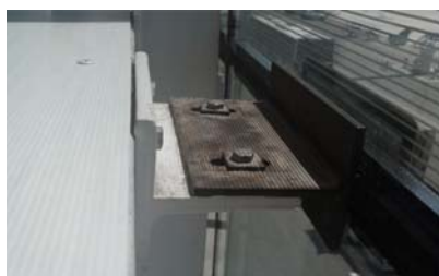
i33. Anclaje del panel al canto del forjado.
