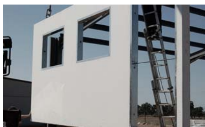
i26. Panel prefabricado de fachada con huecos y premarcos colocados.
