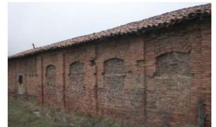
i29. Muro de fábrica portante. Una hoja ligera exterior permite la mejora energética y renovación visual de la fachada.
