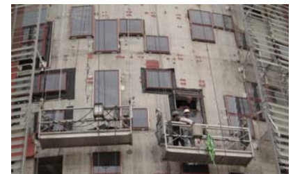
i34. Sellado de huecos. Torre Agbar, Barcelona.
