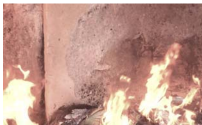
i12. Efecto spalling en el hormigón.
