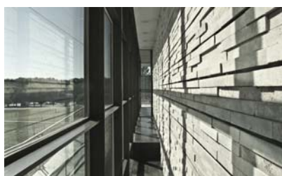
i22. El muro trombe se basa en el aprovechamiento de la inercia térmica de la piedra para el acondicionamiento térmico en el interior.
