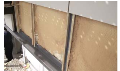
i27. Poliuretano proyectado sobre la cara exterior de la hoja interna.
