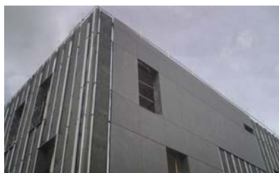
i04. Fachada ventilada.
