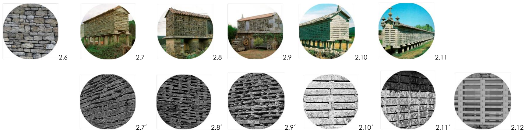
2.6 Muro de mampostería de granito
