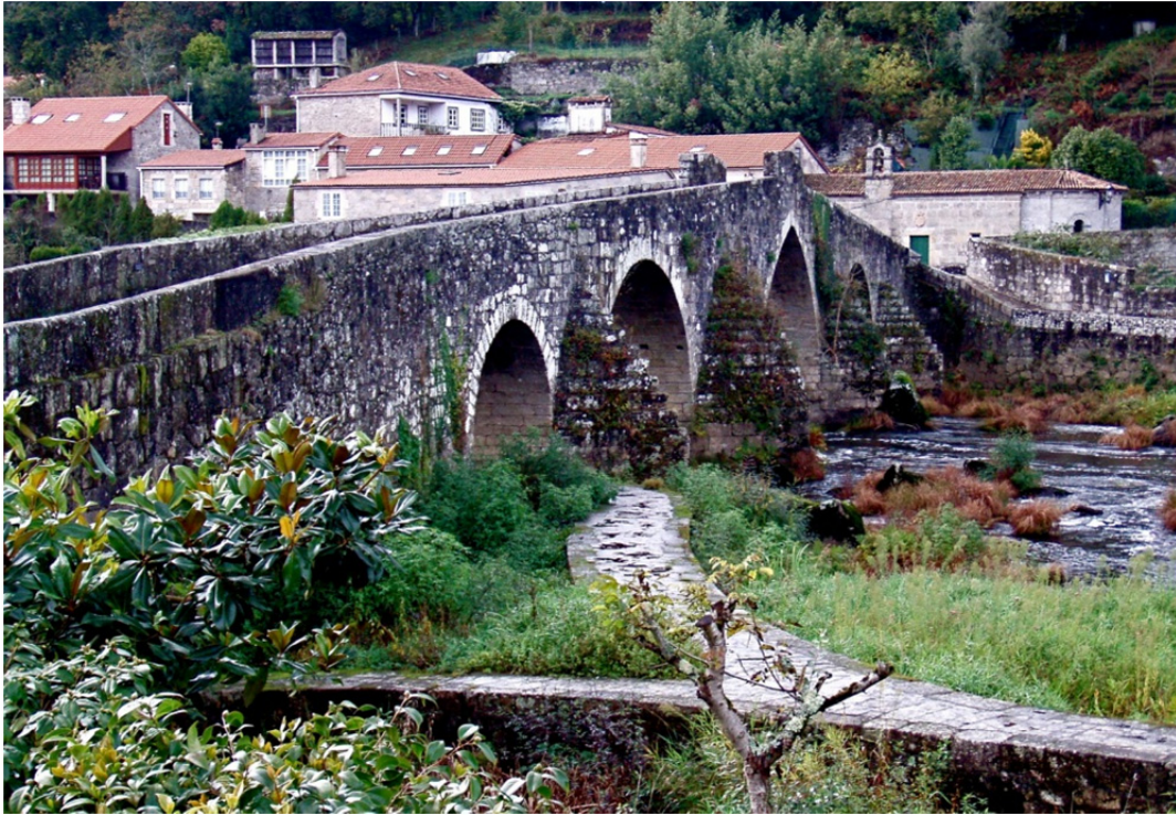
Fotografía 7: Puente de Pontemaceira
