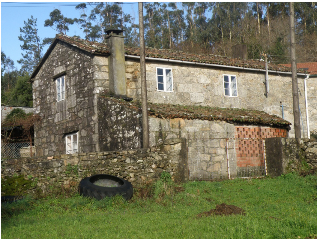
Fotografía11: Fachadas sur y este
