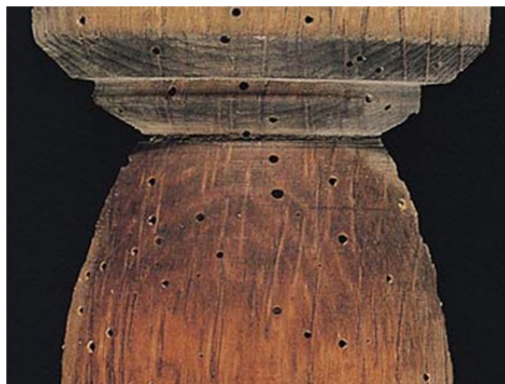
Fotografía 26: Daños producidos en la madera
