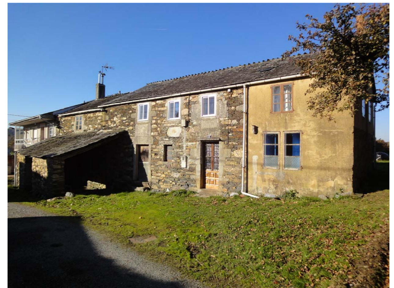
EDIFICIO A REHABILITAR
