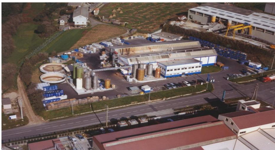
Figura 1. Vista general aérea de las instalaciones de ARTEIXO QUÍMICA S.L.U.
