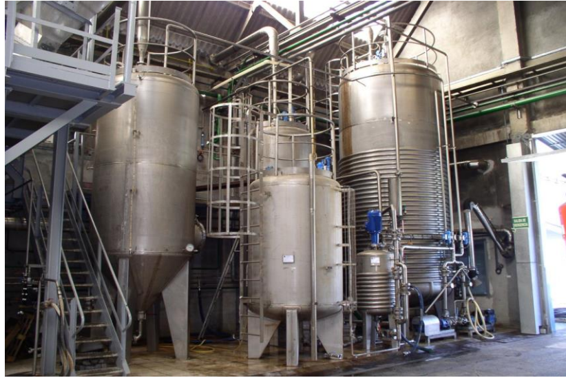
Figura 12. Instalación para la síntesis de la DMBA.
