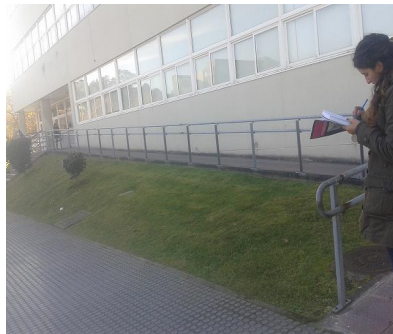
Figura XXVIII: La rampa es accesible, pero falta una barandilla
