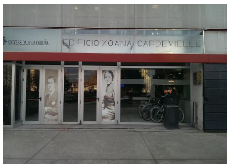
Figura XXXVII: Las puertas de acceso no dejan la zona de paso suficiente
