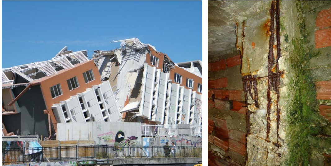
Imagen 5: Efectos del terremoto de Chile febrero de 2010 (izqda.); Imagen 6: Corrosión de armaduras, Poblado Peña del Seo fotografía tomada en 2013 (dcha.)
