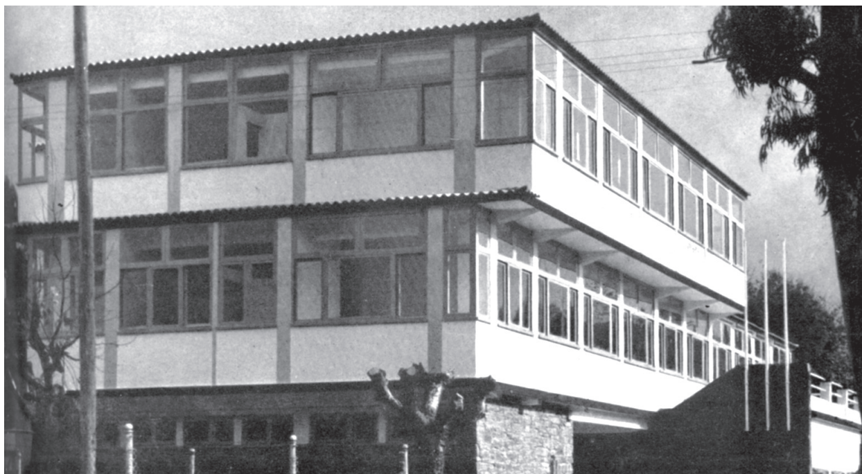
10 Casa Sindical, Betanzos; detalle de las galerías.
