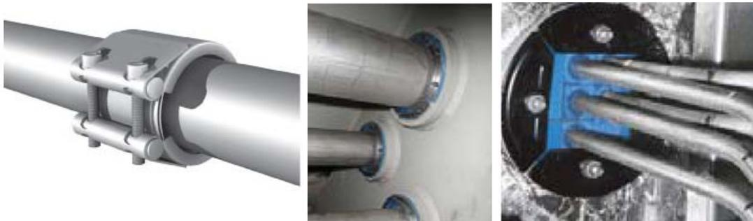
**Figura 4-30: Uniones Straub y Penetraciones Comerciales**
