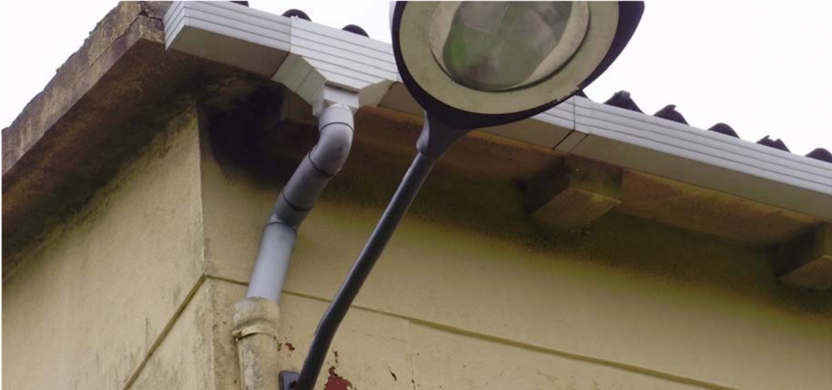
Vista de los pares de la estructura saliendo bajo el voladizo de la cubierta.
