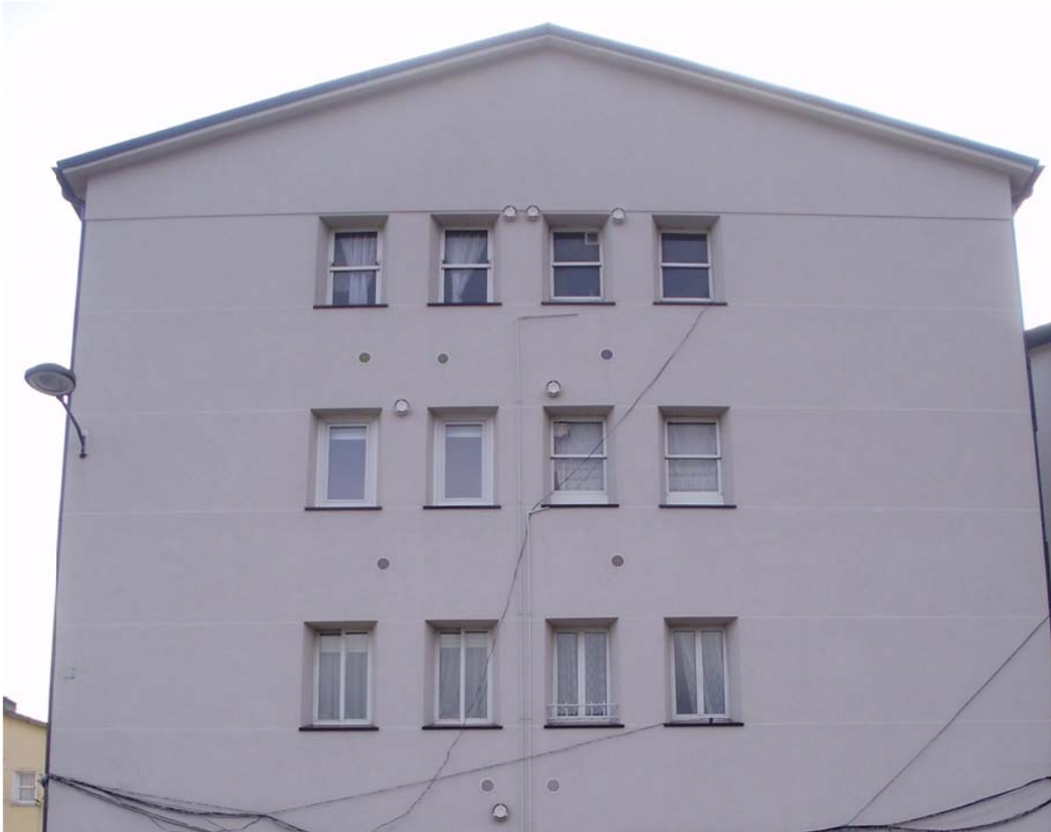
Bloque rehabilitado que incorpora diferentes tipos de materiales y apertura en las ventanas (Guillotina, corredera y de eje vertical).
