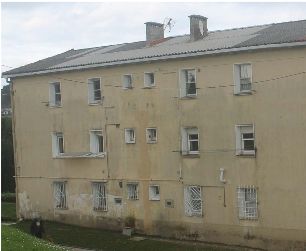
Tres rejas diferentes en dos pisos en el bloque nº 14.
