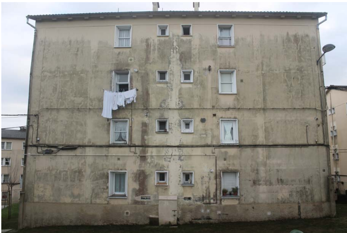
Vista del cerramiento exterior del bloque 12.
