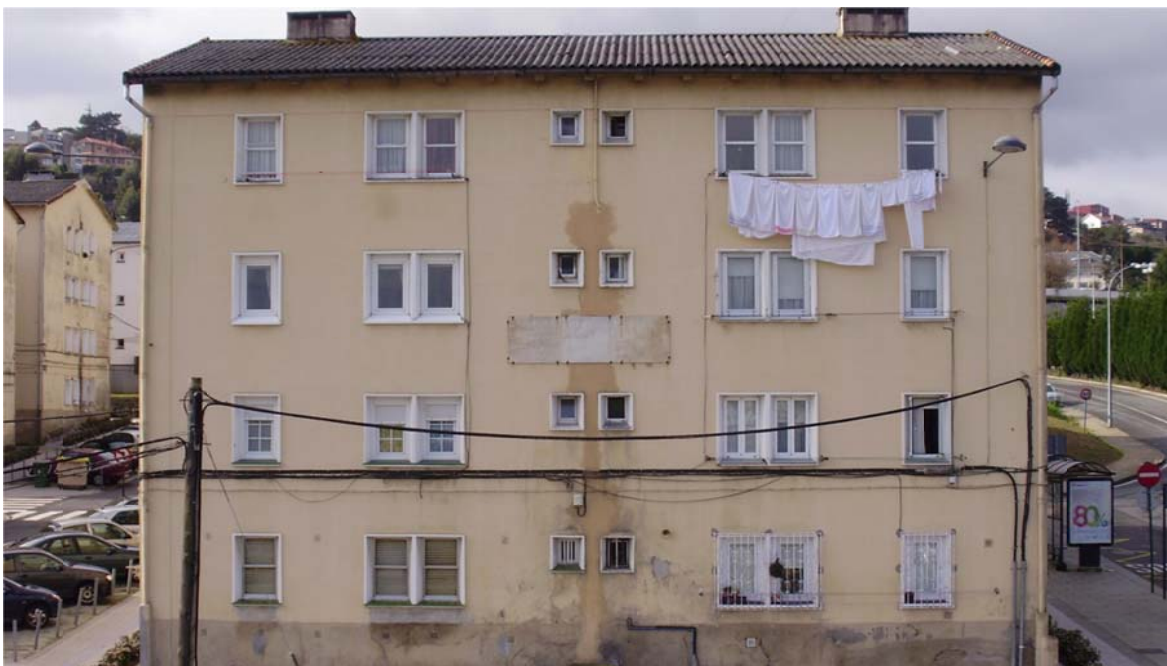
Bajante empotrada en el cerramiento.
