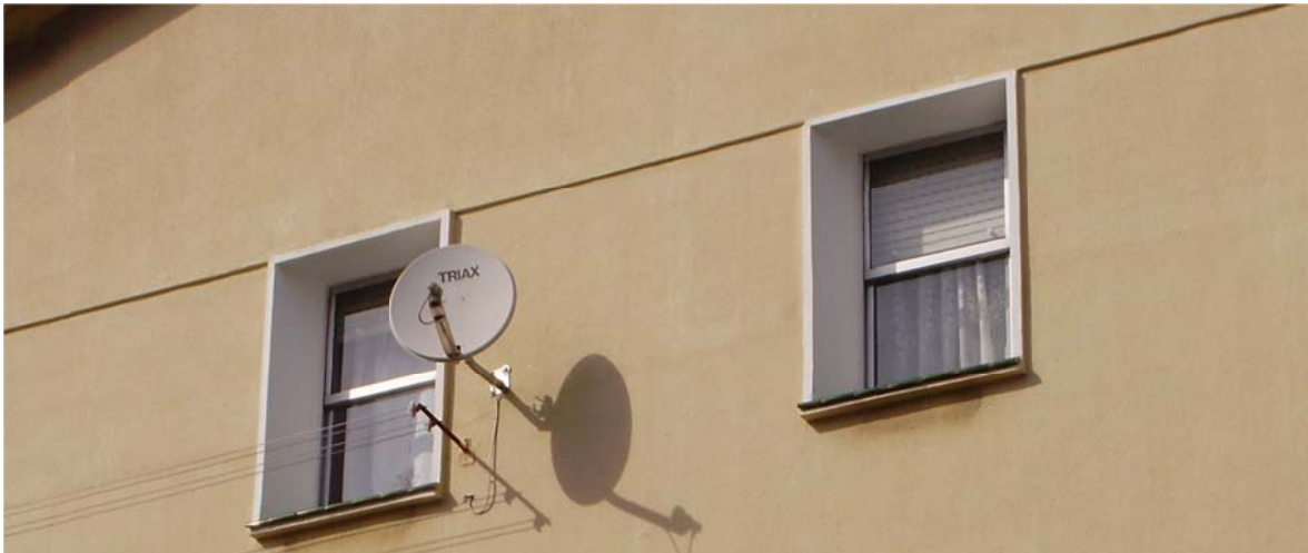
Antena parabólica para ver TV por satélite en el bloque nº4.
