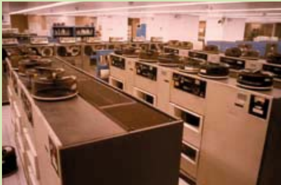
◀ Los discos IBM 3330 con unidades de cinta 3803, de 100 a 200 Mb de capacidad, c. 1982.
