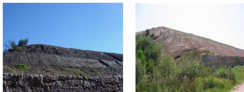
Figura 2.7. Taludes con bermas en un vertedero controlado de serrines.
