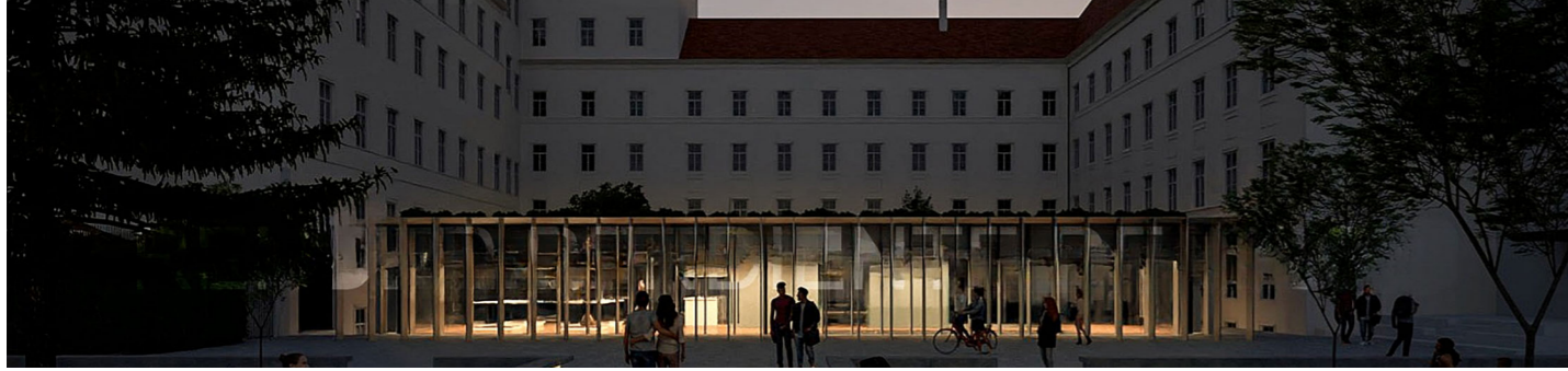
vista nocturna general de la intervención
