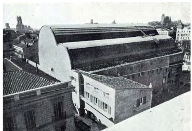
Figura 4. Inauguración el 29 de febrero de 1936. Obsérvese que falta por construir el volumen destinado a restaurante. (Huarte y Cía, S. L. Construcciones. Frontón Recoletos. Volumen 5 . Madrid: Tipografía Artística).
