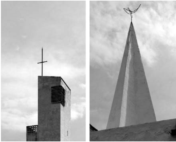
Fig. 03. José Luis Fernández del Amo Moreno, El Realengo (Alicante), 1953; detalles del campanario y del pináculo sobre el baptisterio.
