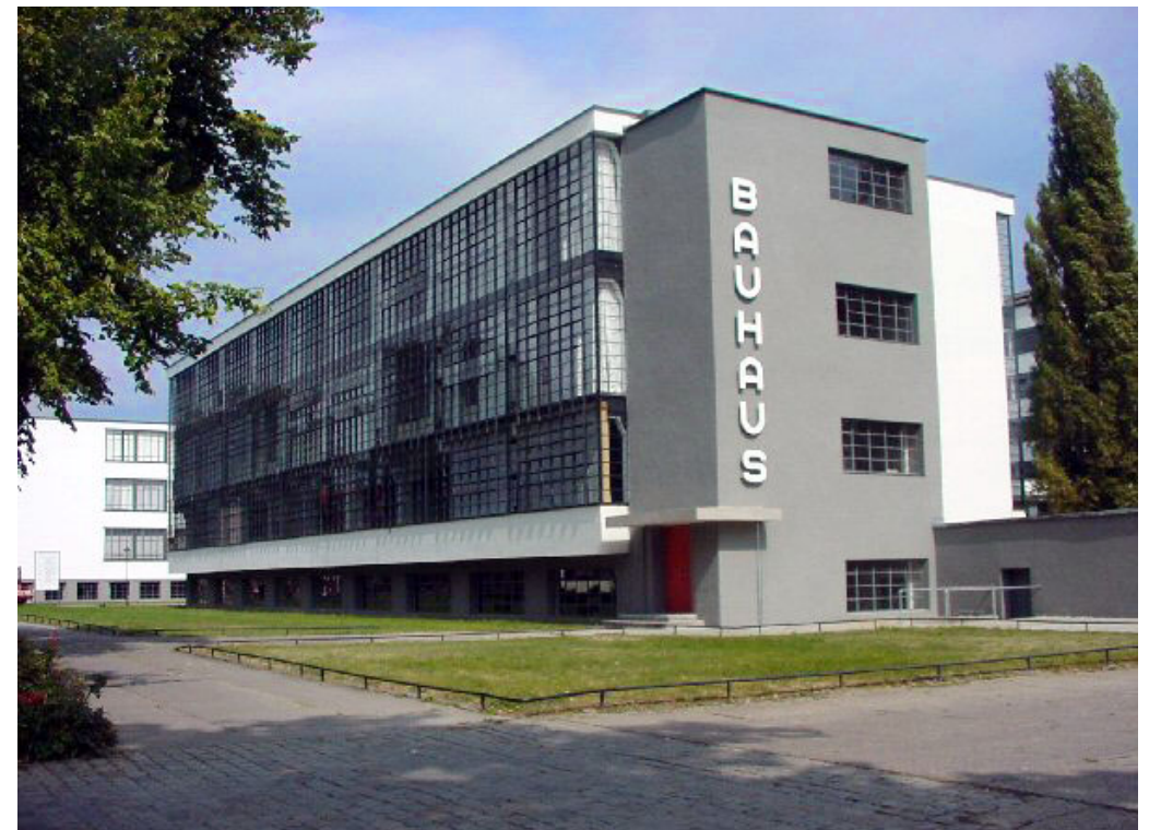
Edificio de la Bauhaus en Dessau. W.Gropius. 1925
