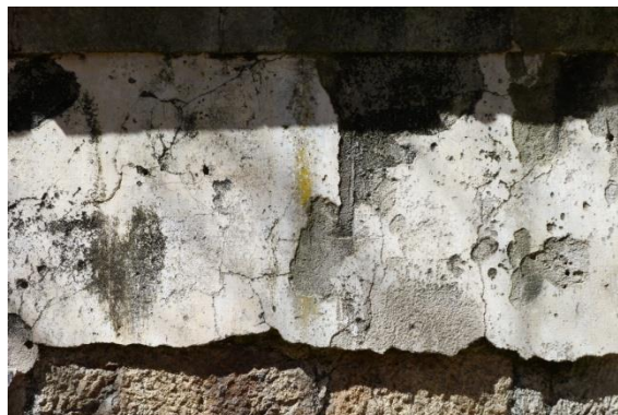
IMAGEN 46: DETALLE ENFOSCADO DE CAL
