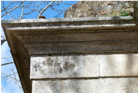
IMAGEN 25: DETALLE CORNISA GRANITO
