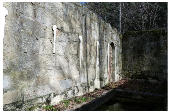
IMAGEN 44: MURO BAÑERAS 03 Y 04
