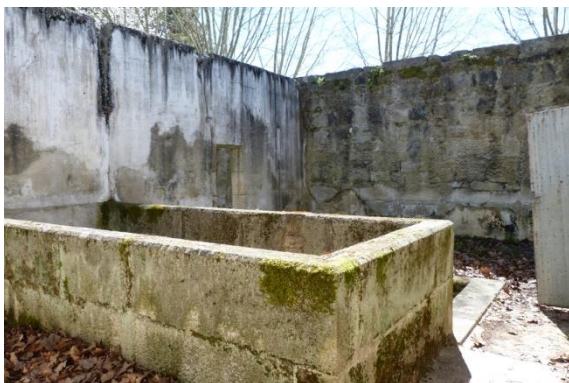
IMAGEN 39: VISTA ZONA ENTRADA
