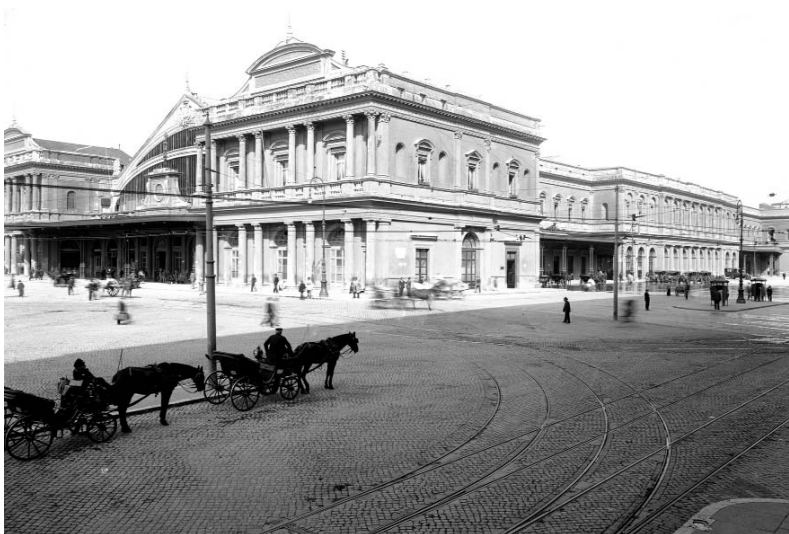
Fig. 01. La estación Termini a finales del siglo XIX.
