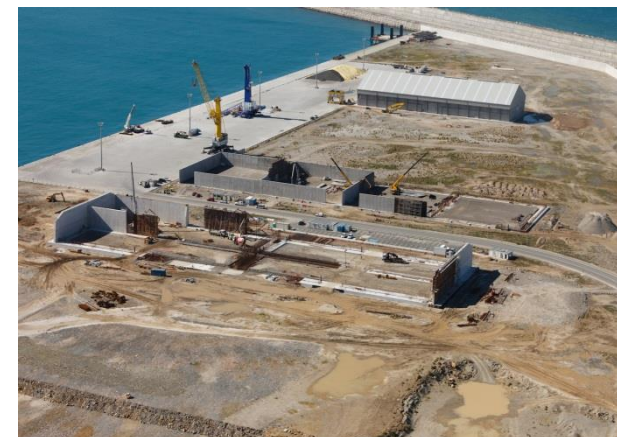
Avance de las obras de las naves de almacenamiento. Marzo 2015 Fuente: Autoridad Portuaria de A Coruña
