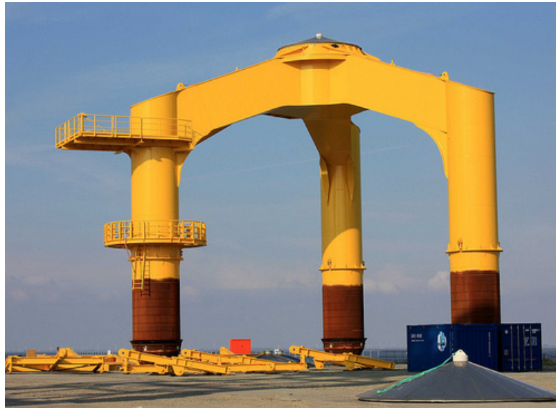
Ilustración 6. Estructura tripilote (Profundidad < 30 m).
