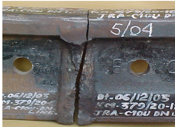
Ilustración 19. Ejemplo de rotura por fatiga en la unión soldada entre 2 railes.
