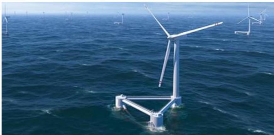
Ilustración 10. Ejemplo real de un molino offshore con plataforma flotante.
